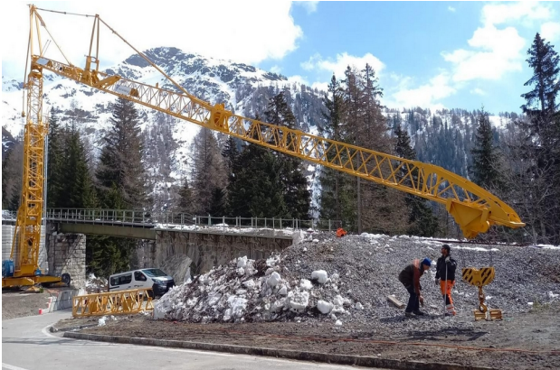
Sanierung des Lammenviadukts
